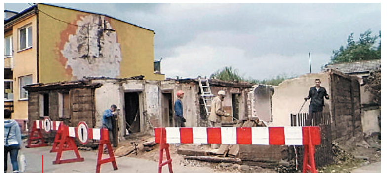
Prace na Sierpeckiej trwały już w minionym tygodniu, rozcinane elementy ze spalonego domu były wywożone z miejsca pożaru
