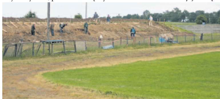
Obecnie trwa rozbiórka starej części trybun stadionu sportowego
