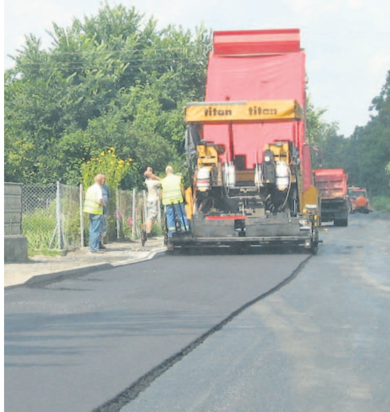
Prace modernizacyjne na trasie Mokowo-Wylazłowo postępują w bardzo szybkim tempie. Niebawem kierowcy bez żadnych przeszkód będą mogli z niej korzystać
