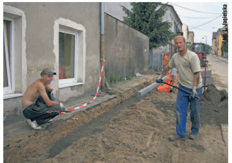
Budowa chodników przy ul. Kilińskiego trwa
