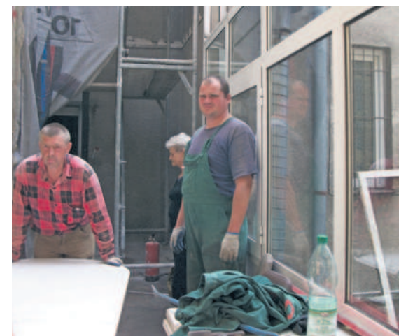
Pracownicy firmy MS-BUD rozpoczęli od remontu korytarzy
