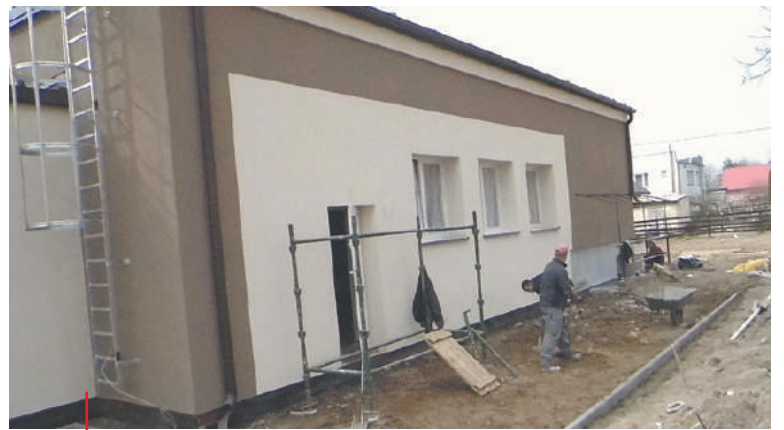
Budynek zyskał nową elewację
