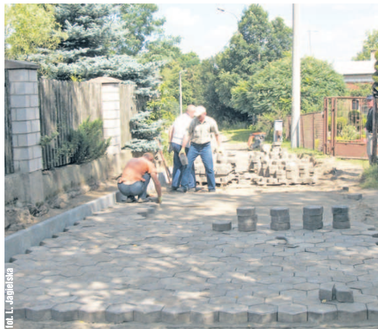
Prace przy ul. Kłokockiej rozpoczęły się w minioną środę
