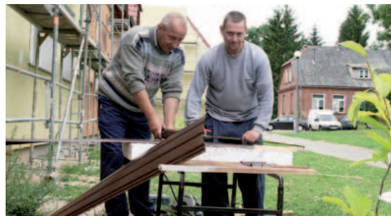
Zbigniew i Łukasz, pracownicy zakładu remontowo-budowlanego, przycinają elementy podbitki dachu
