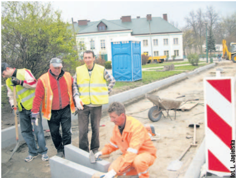
Do końca czerwca potrwa modernizacja placu. Po tym czasie ma się tam pojawić kilka miejsc parkingowych więcej
