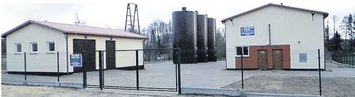
Nowa stacja uzdatniania wody daje możliwość podłączenia kolejnych odbiorców
