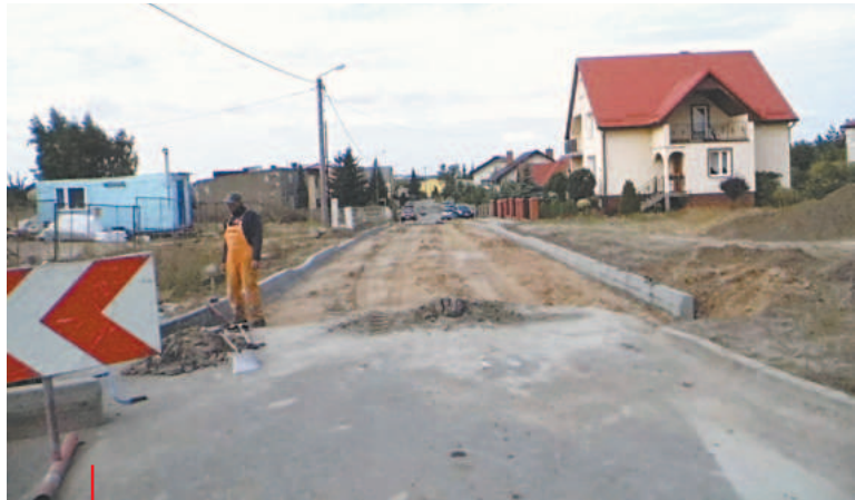
Prawie 50 metrów ulicy Żeromskiego pokryje wkrótce asfalt
