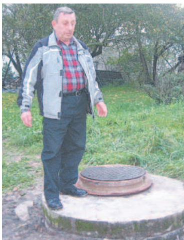
Jerzy Pawlicki i feralna studnia kanalizacyjna przy jego działce – mówi Jerzy Pawlicki.
