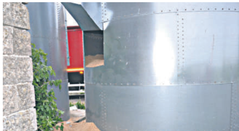
Strażacy wycięli w zbiorniku otwór, by wyciągnąć mężczyznę
