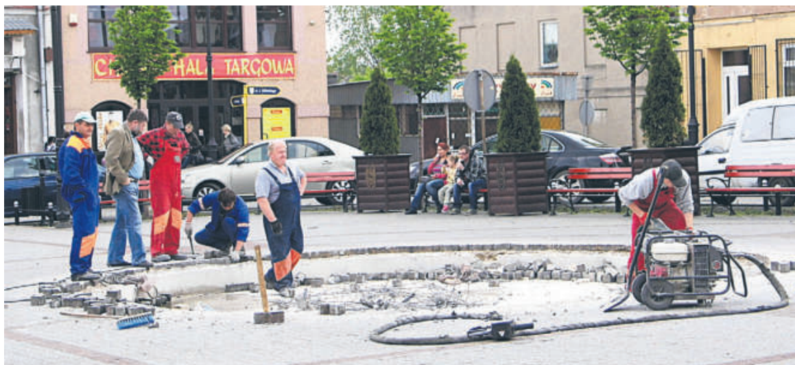
Nie jest to budowa nowej fontanny (choć na pierwszy rzut oka może tak wyglądać), lecz remont dotychczasowej
